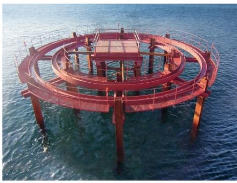
油圧パイプロ(振動作業)を使用し、『鋼管矢板』打ち込みに使用した導杭を撤去します。
