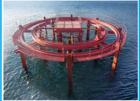
油圧バイプロ(振動作業)を使用し、『鋼管矢板』打ち込みに使用した導杭を撤去します。
