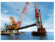
油圧バイブロ(振動作業)と油圧ハンマ(打撃作業)を使用し、導枠に添って『鋼管矢板』を海底地盤に打込みます。
